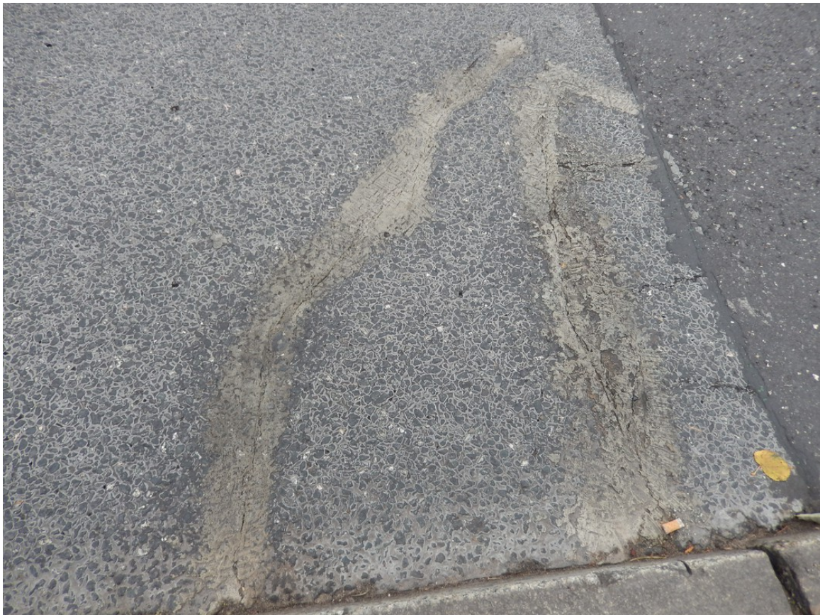
Fot. 1 Spękanie poprzeczne pierwsze
