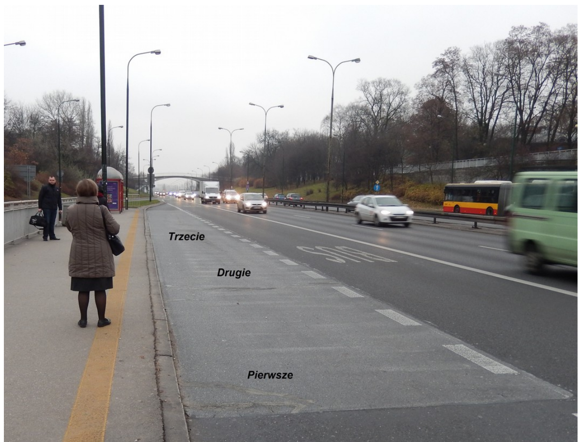
Rys. 4 Umiejscowienie spękań poprzecznych
