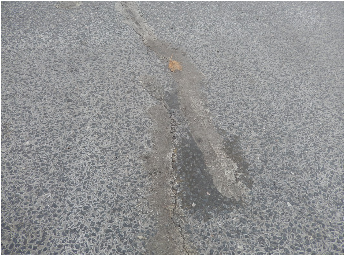
Fot. 5 Spękanie poprzeczne drugie – środkowa część
